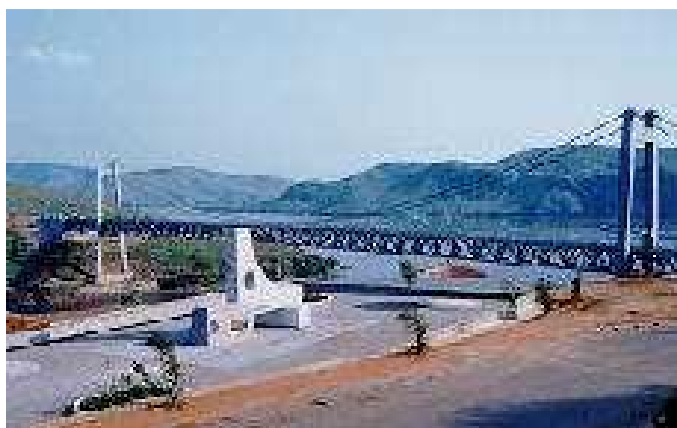
Une vue du pont Maréchal à Matadi sur le fleuve Congo
